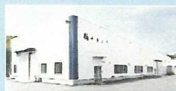
倒壊した工場・施設等の復旧支援
