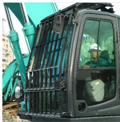
vol.09 解体重機オペレーター 山本 浩さん（佐々部工業株式会社） “工事の始まり”を担う建物解体のスペシャリスト
